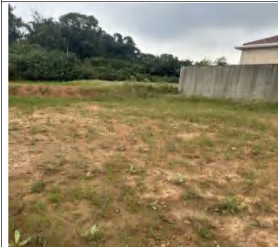
管线工程区撒播草籽
