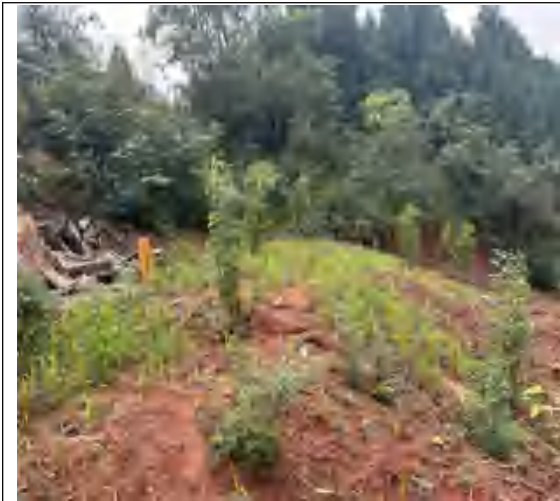
管线工程撒播草籽和栽植乔木
