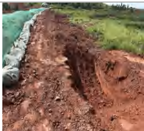
施工便道临时排水沟和临时沉砂池
