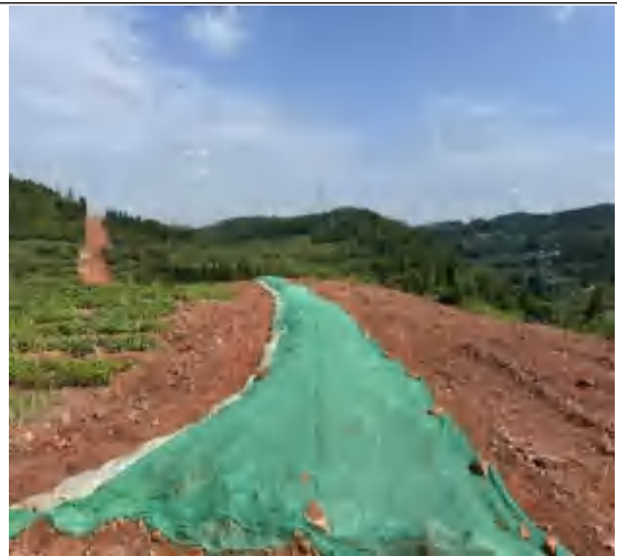
施工便道土袋拦挡和临时遮盖
