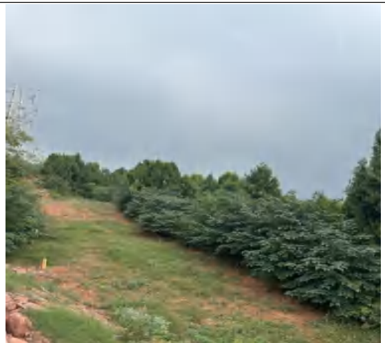
管线工程区撒播草籽
