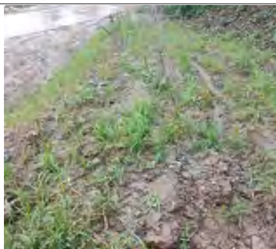
施工便道撒播草籽
