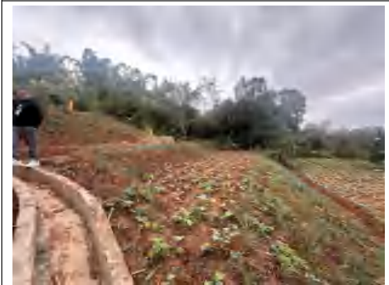
管线工程区截排水沟和土地复耕
