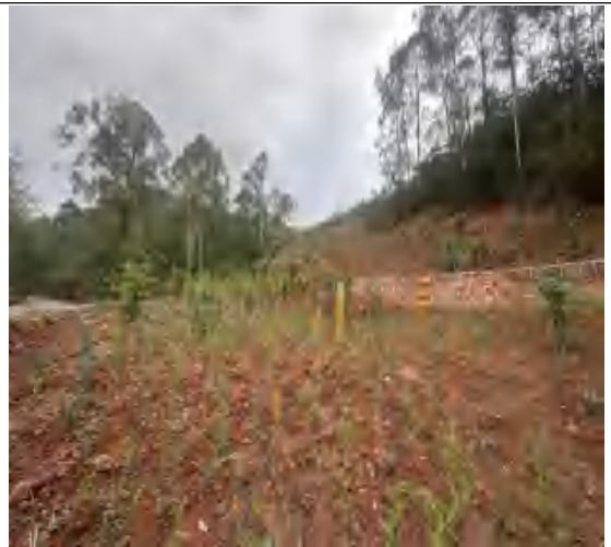
管线工程区栽植灌木和乔木
