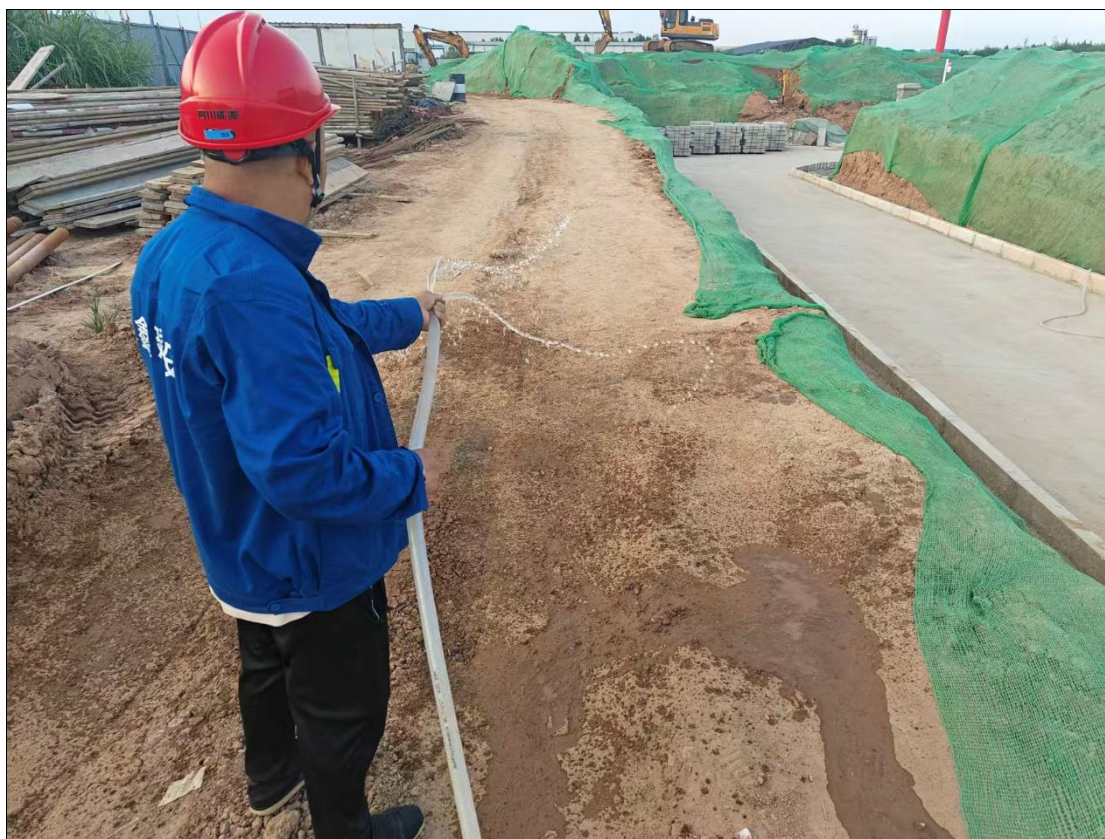
施工区域洒水降尘措施照片
