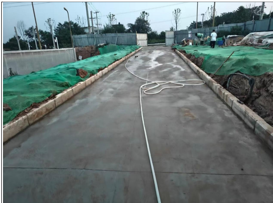
施工期间环保措施落实照片（围挡及防尘网覆盖）
