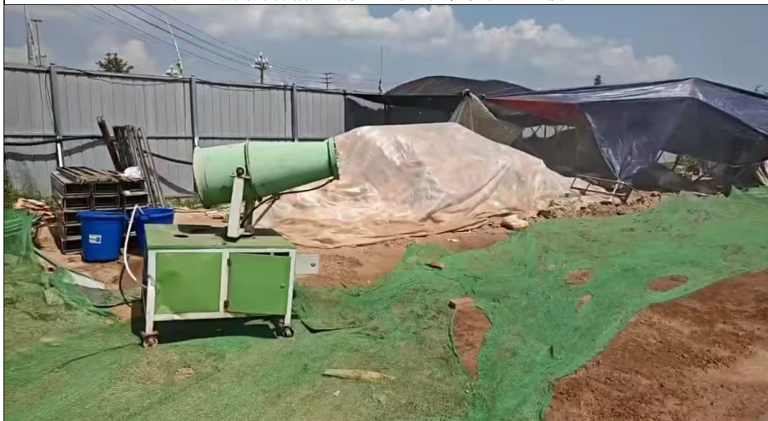
施工期间环保措施落实照片（雾炮除尘）
